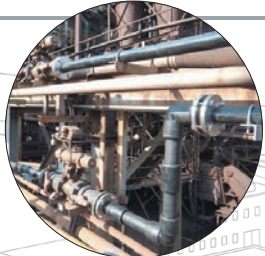
アイボリーブロードパイプ 工場配管 施工現場
