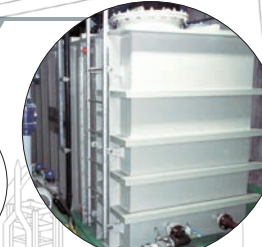
PP製タンク 処理設備 施工現場
