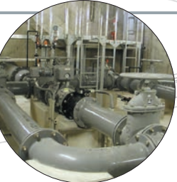
ナイロンコーティング鋼管・継手 施工現場
