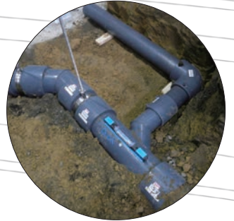
FRPパイプ 施工現場
