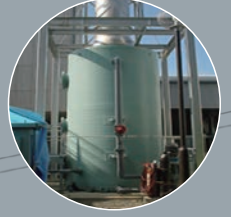
FRP脱臭塔 施工現場
