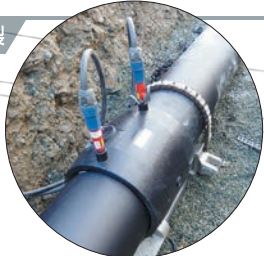
アイボリーブロードパイプ EF接合 施工現場
