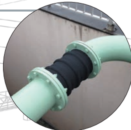
ゴム可とう伸縮継手 アトムジョイント施工現場
