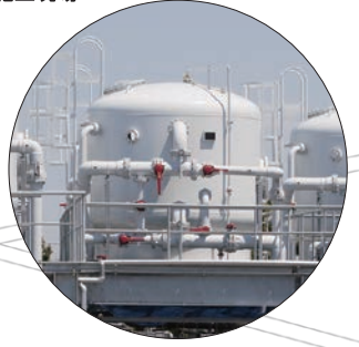
浄水場 施工現場
