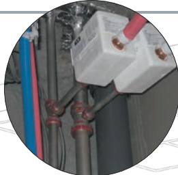
ステンレス鋼管 KKベスト 施工現場
