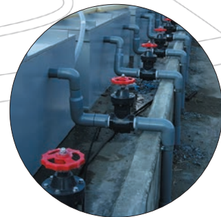
水産・養殖場 施工現場
