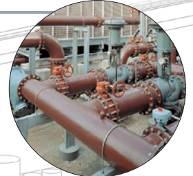
硬質塩化ビニルライニング鋼管・継手 施工現場
