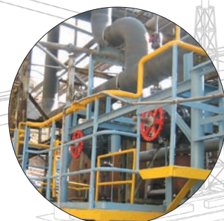
ケミカルプロセス 施工現場
