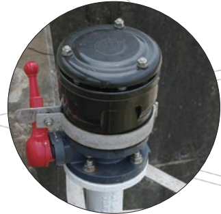
水管橋 施工現場
