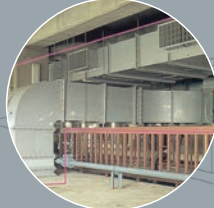
工業用硬質塩化ビニル押出板 耐熱用アングル(HI プレート) 角ダクト 施工現場
