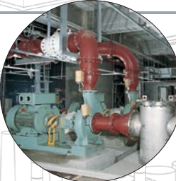
硬質塩化ビニルライニング鋼管・継手 施工現場
