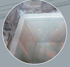
PPビット更生 施工現場
