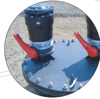
農水パイプライン 施工現場
