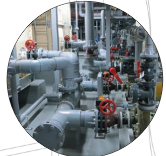
水族館 施工現場
