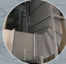
PVC製 角ダクト 製作実績
