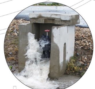
田んぼへの自動給水 自動給水栓 施工現場
