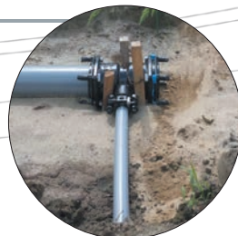
農水パイプライン スプーンMジョイント 施工現場
