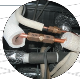
新冷媒HFC 用継手 おっぞんくんB 施工現場
