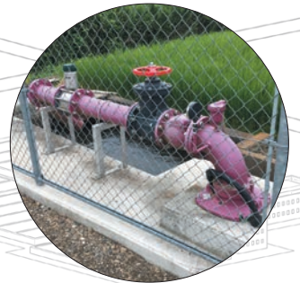
用水路 施工現場
