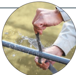
シリコンゴムテープ 水漏れ御用 漏水補修現場
